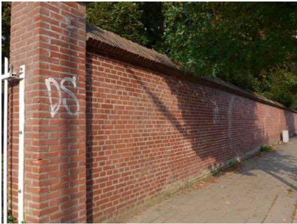
afb. 46 Lange kloostermuren met ezelsruggen en pilasters. Vanwege de volle voeg en portlandspecie is er weinig kans op muurvegetatie. Rechts 19e eeuwse muur met rij van knotlindes (zomerlindes en Hollandse lindes).
