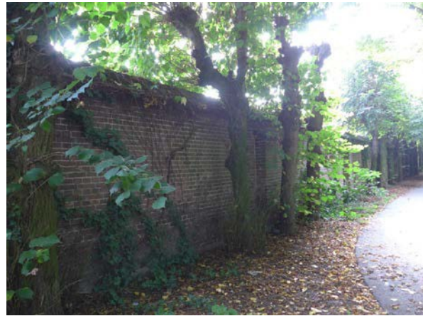
afb. 46 Lange kloostermuren met ezelsruggen en pilasters. Vanwege de volle voeg en portlandspecie is er weinig kans op muurvegetatie. Rechts 19e eeuwse muur met rij van knotlindes (zomerlindes en Hollandse lindes).
